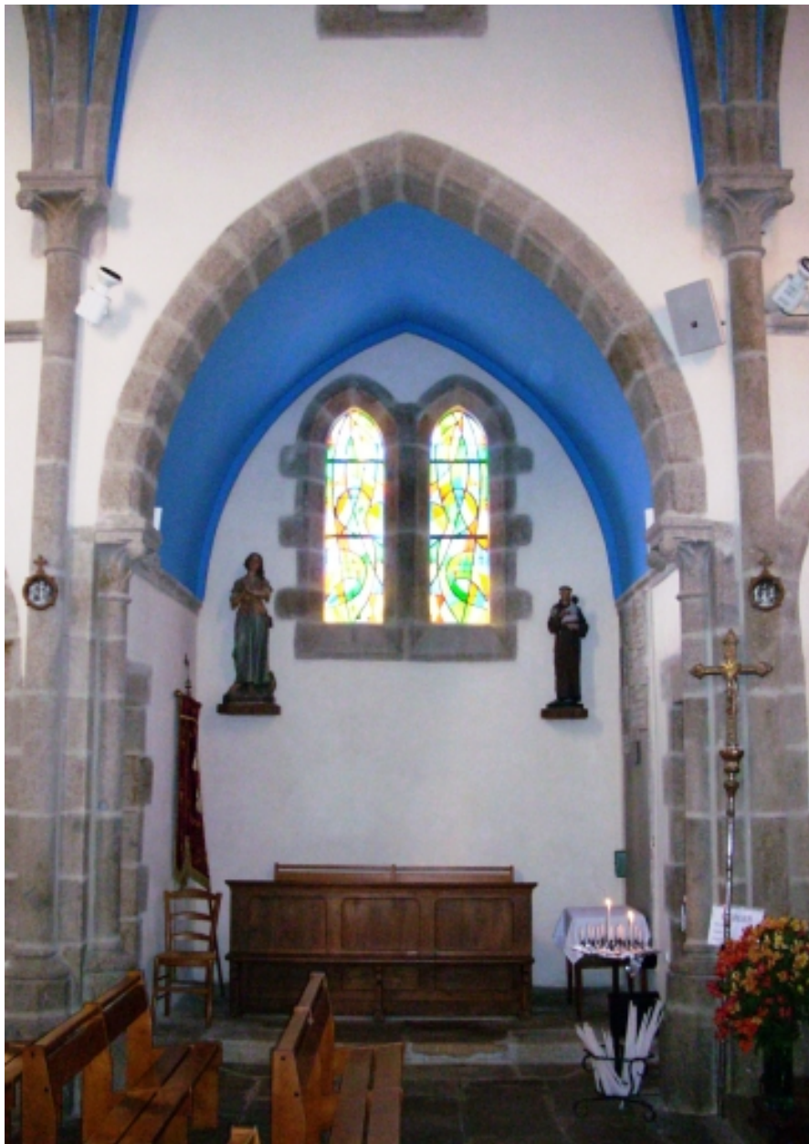
Plouarzel, église de Trézien : vue de la chapelle latérale sud depuis le nord
