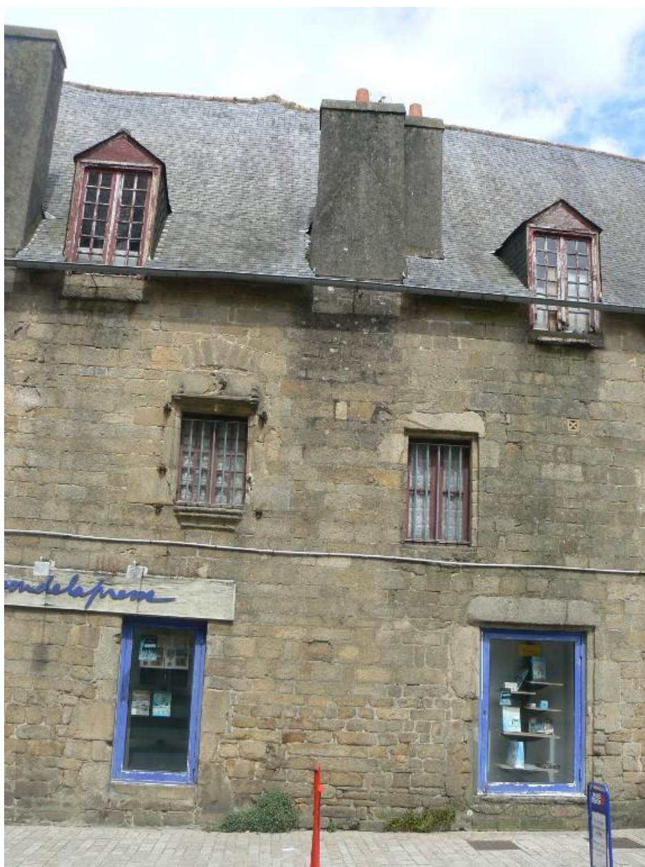
Détail du mur gouttereau en maçonnerie
