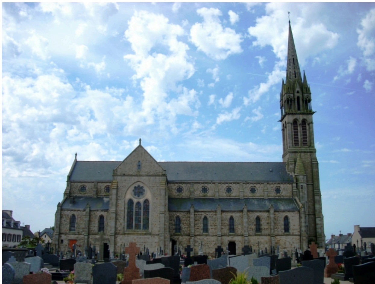
Plouénan, église paroissiale Saint-Pierre : élévation nord
