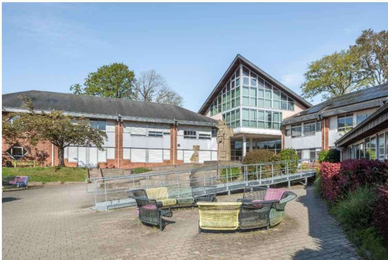
Vue d'ensemble de l'entrée prise du sud-est. Patrick Pincemaille et Ruelland-Perche-Héraud, architectes, 1986.
