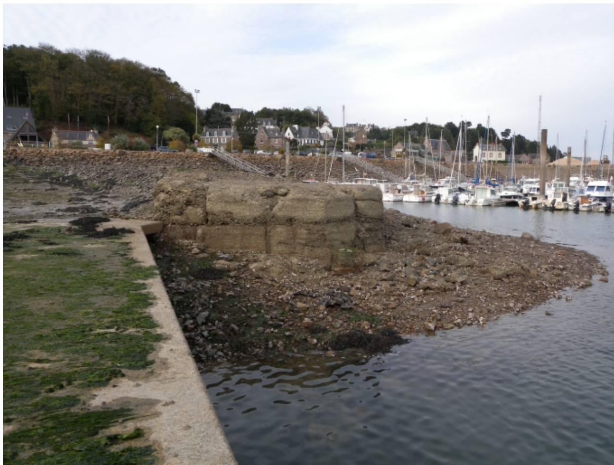
Vue des vestiges de l'ancienne jetée bombardée par les Allemands
