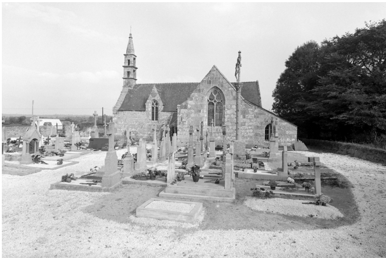
Elévation sud : vue prise du sud est
