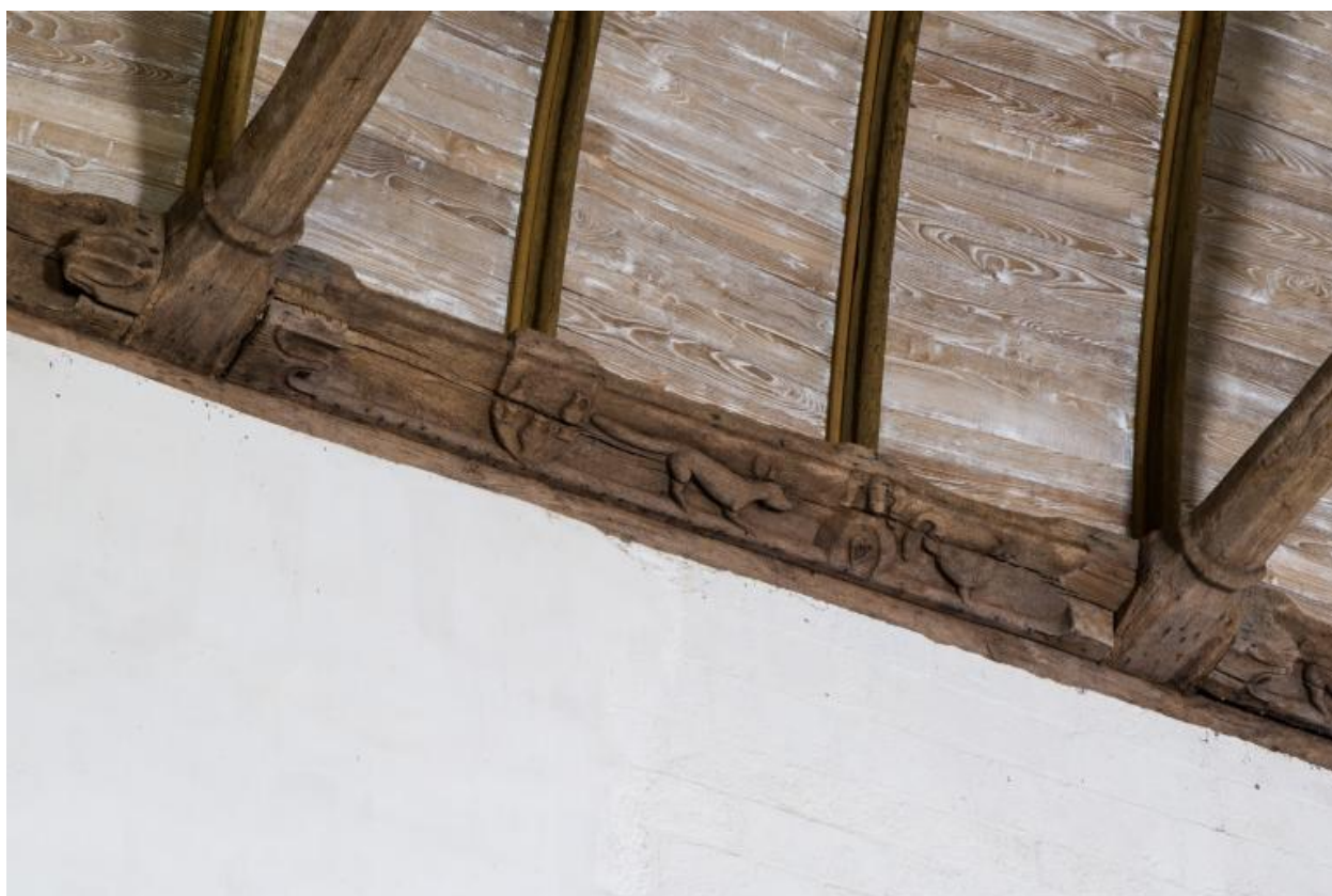
Vue de détail : sablière sur le mur sud de la chapelle.
