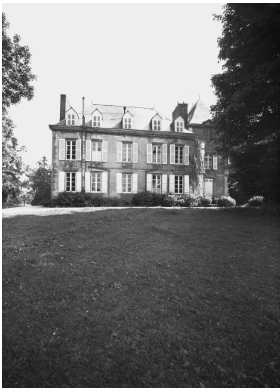
Vue générale de la façade nord
