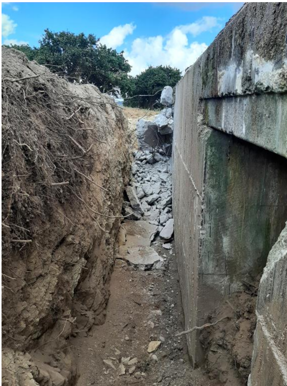
Vue de la déconstruction : mur et entrée ouest (25 septembre 2022)
