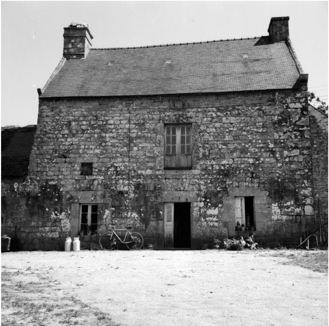
Maison (parcelle 298) : vue d'ensemble de la façade ouest
