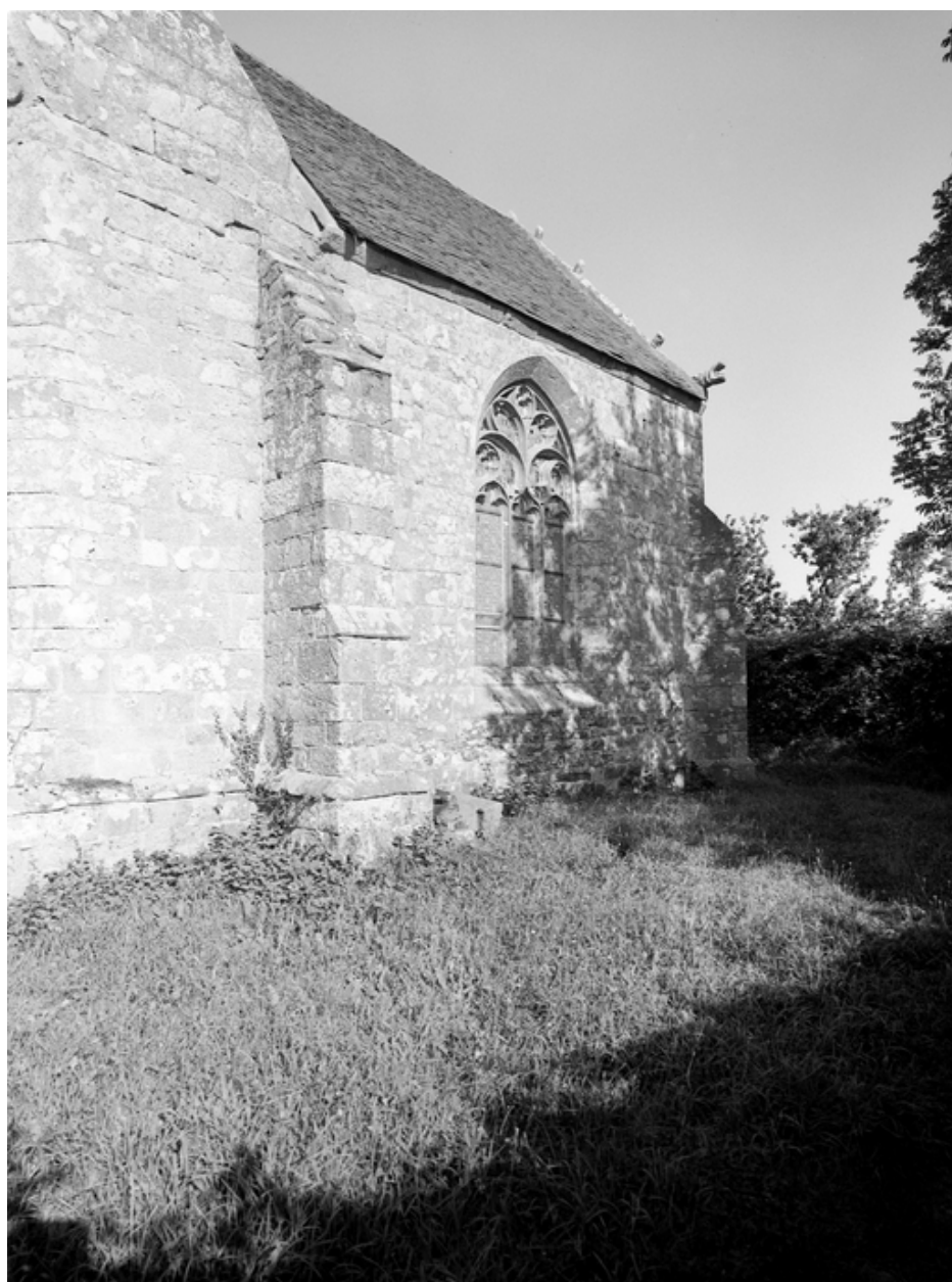
Façade est : vue du mur est du bras nord du transept
