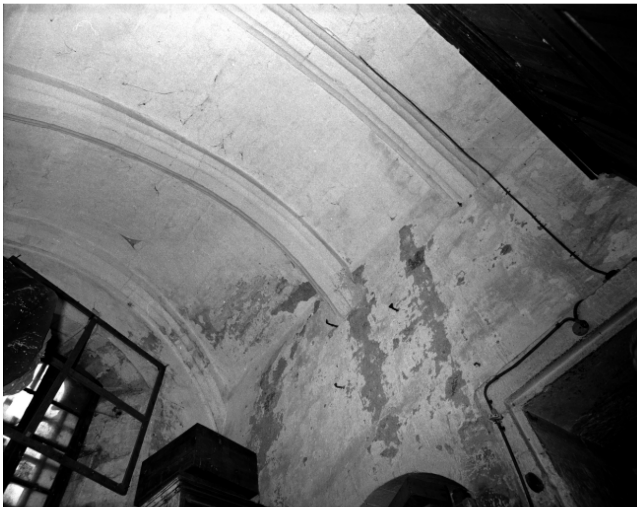
Vue de détail de la voûte.
