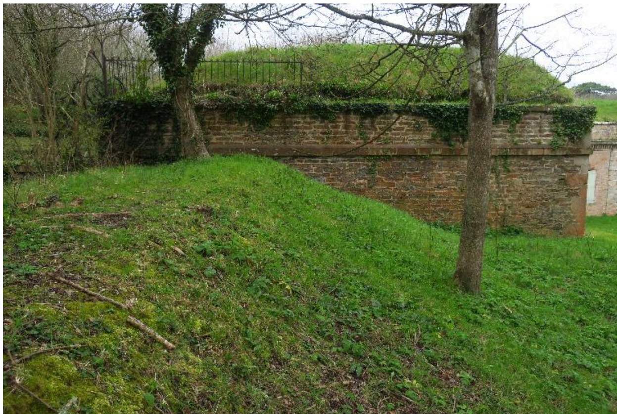
Le Palais, enceinte urbaine, bastion 20, grille défensive.
