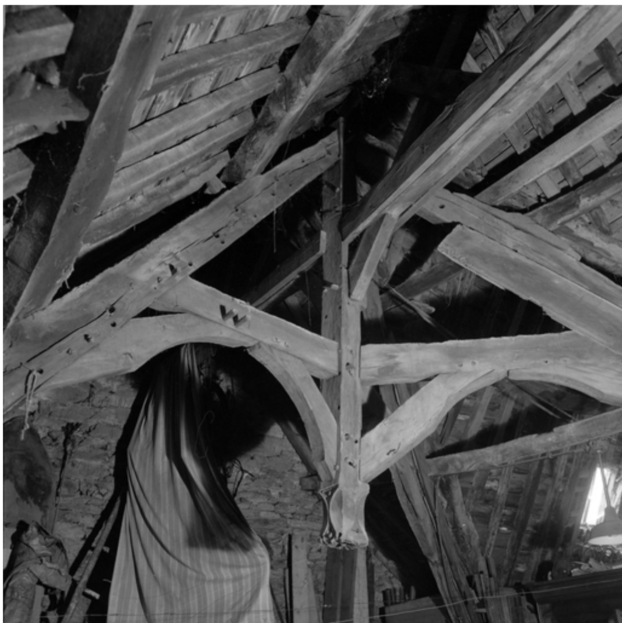
Charpente, vue d'ensemble de l'assemblage central.
