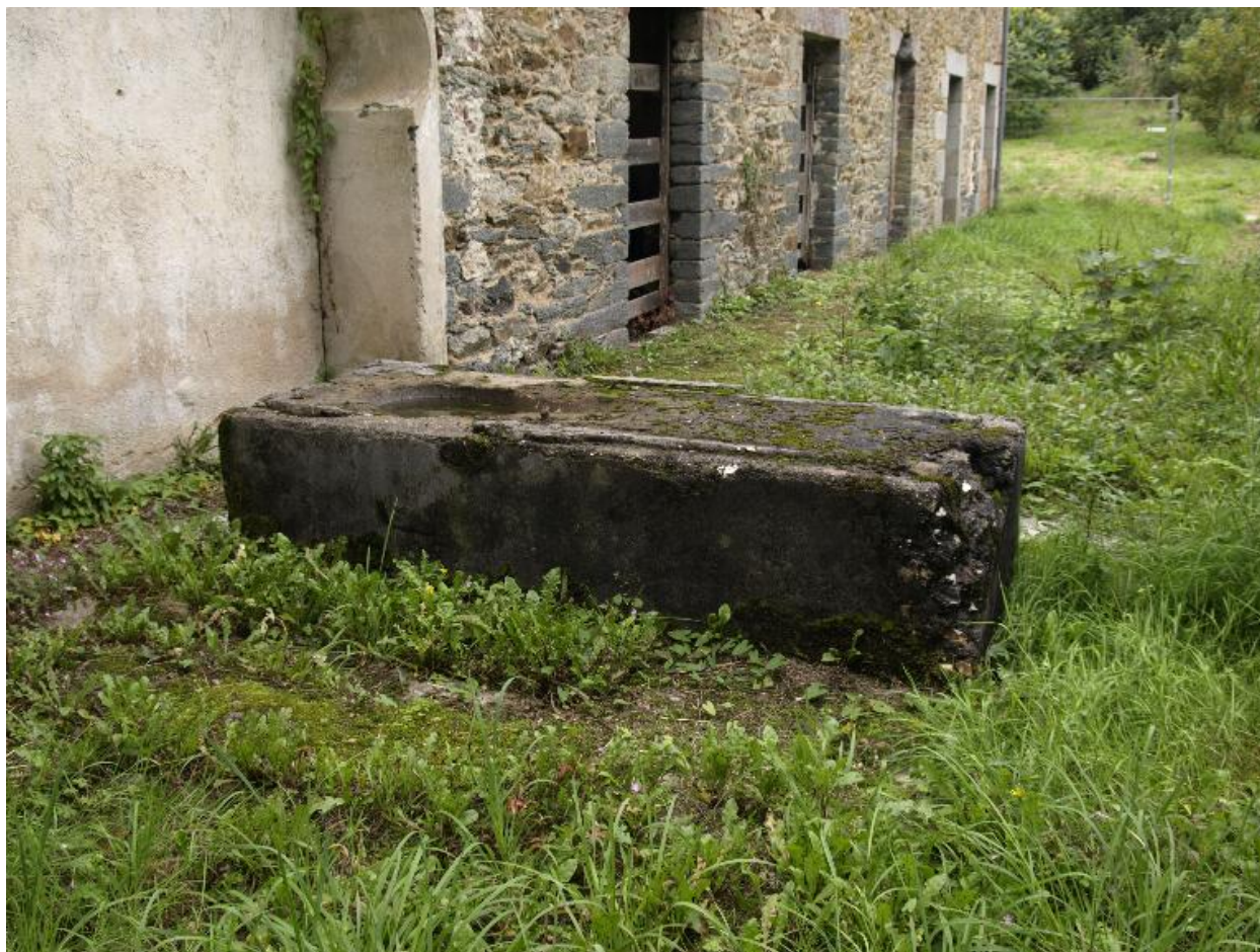
Support du moteur (à l'arrière du bâtiment principal). Etat en 2015
