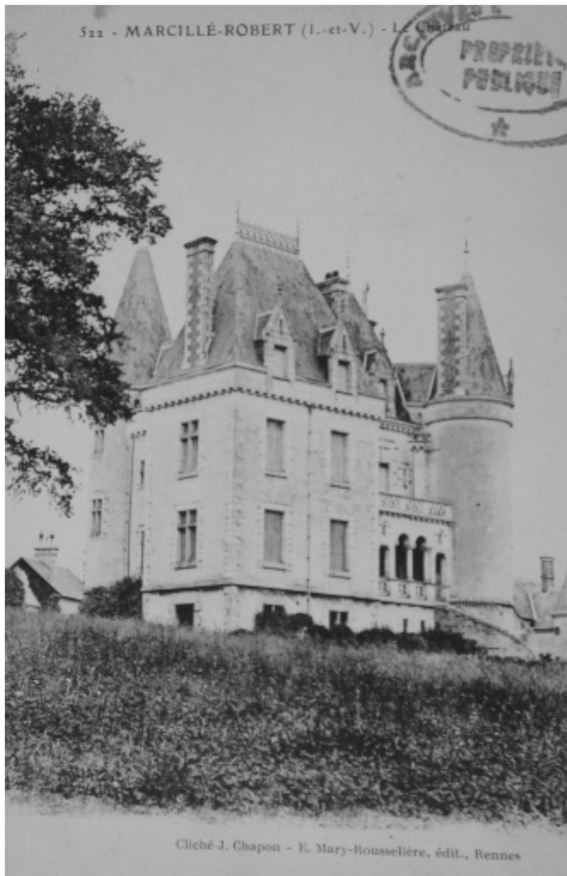
Vue générale de la façade postérieure
