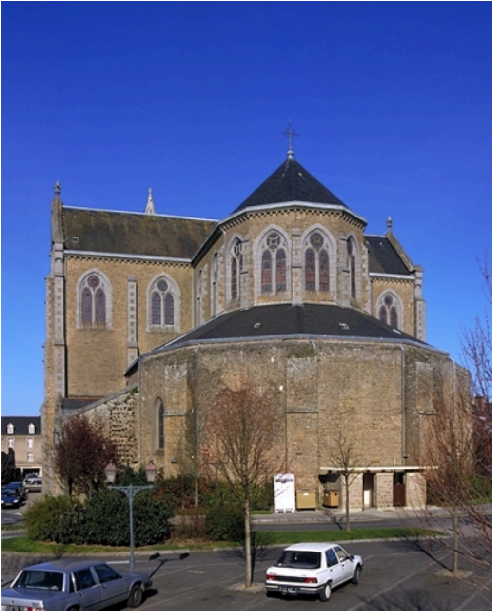
Vue générale est
