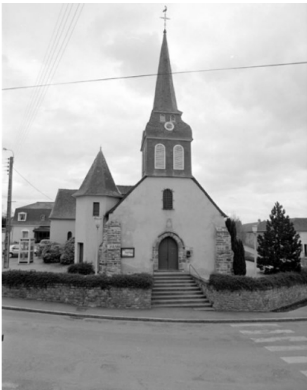
Elévation ouest : vue générale
