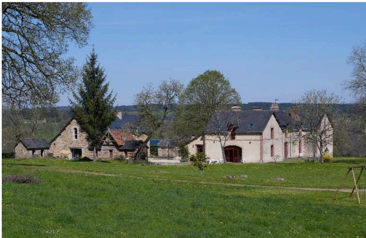
Vue de situation des dépendances du château
