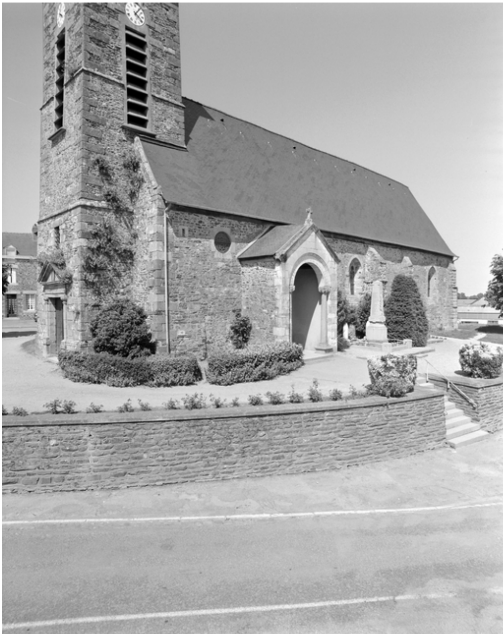
Elévation Sud-Ouest : vue générale
