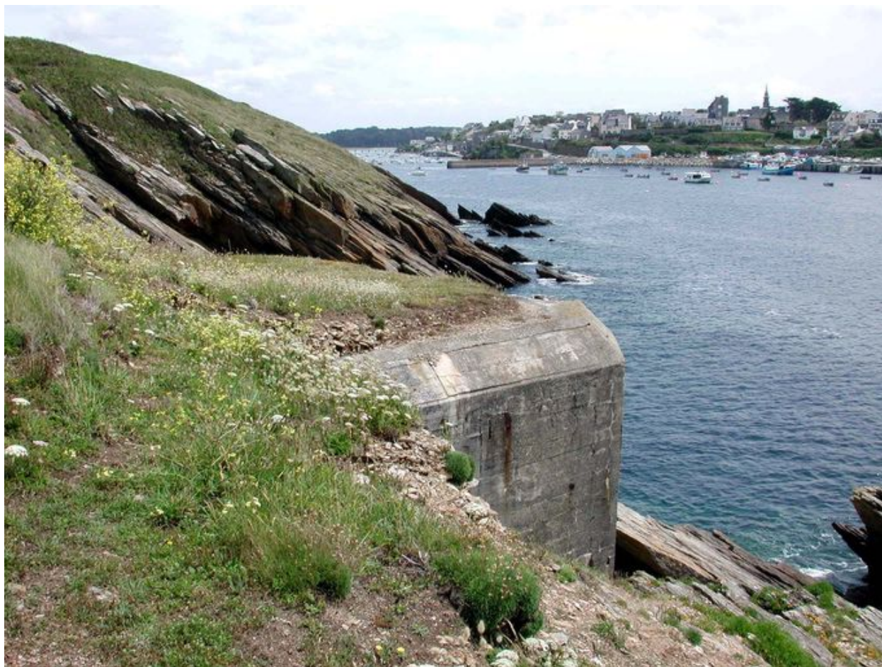
Vue de situation de la casemate de type 505
