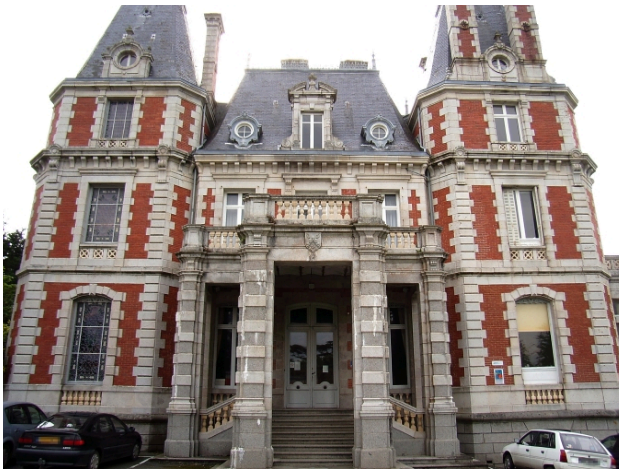
Vue générale (élévation antérieure)
