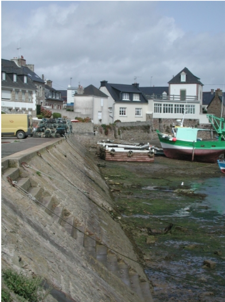
Vue du fruit du mur de quai Sud
