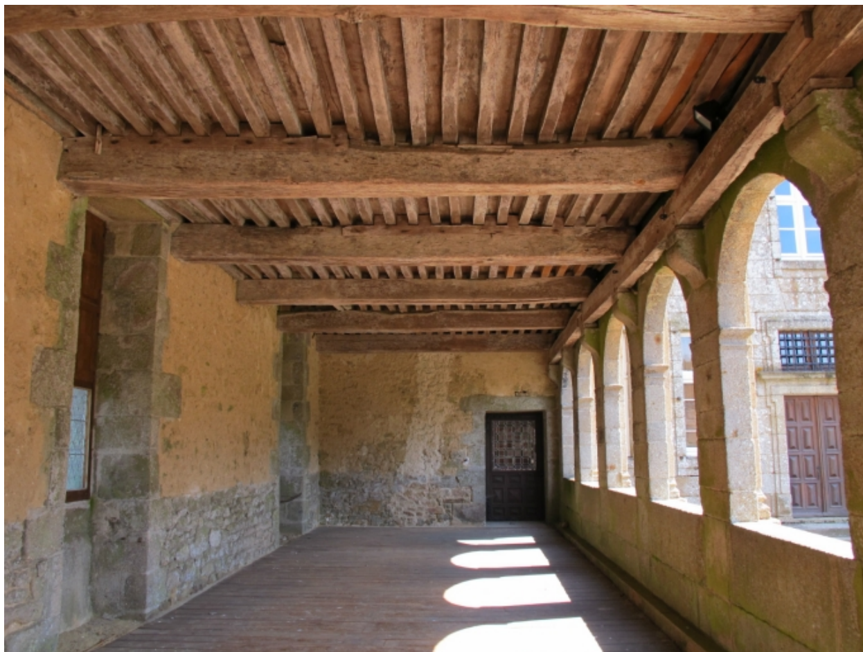
Vue intérieure de la galerie
