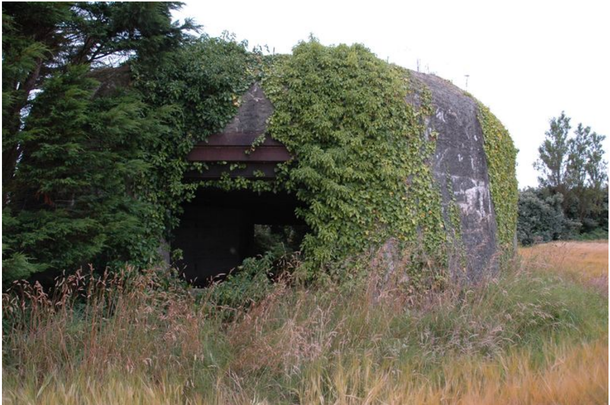
Vue de l'une des quatre casemates de type 669 : côté embrasure (état en 2008)
