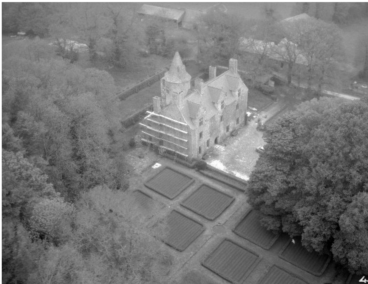
Vue aérienne prise du sud est
