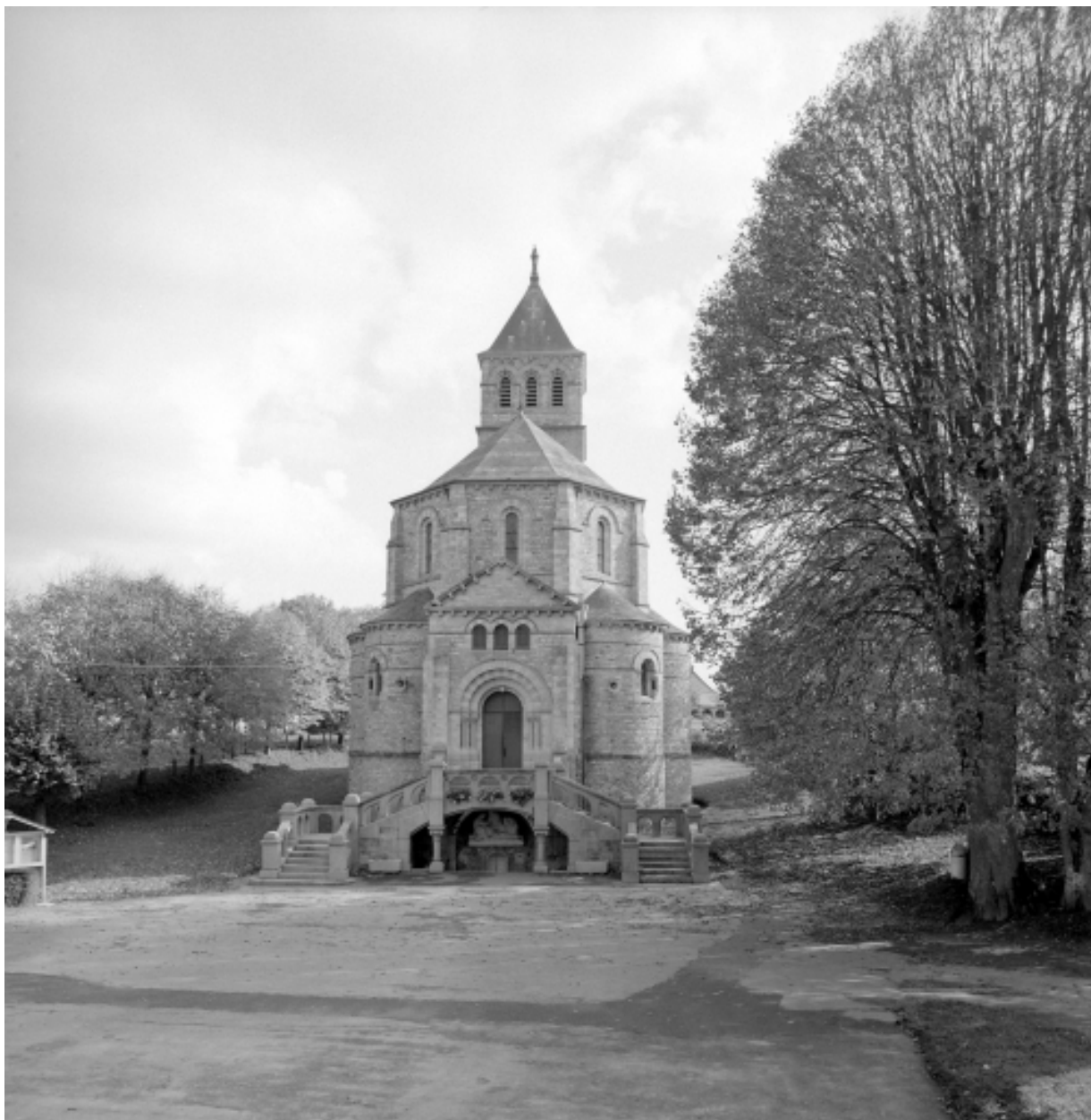
Elévation Ouest : vue de situation
