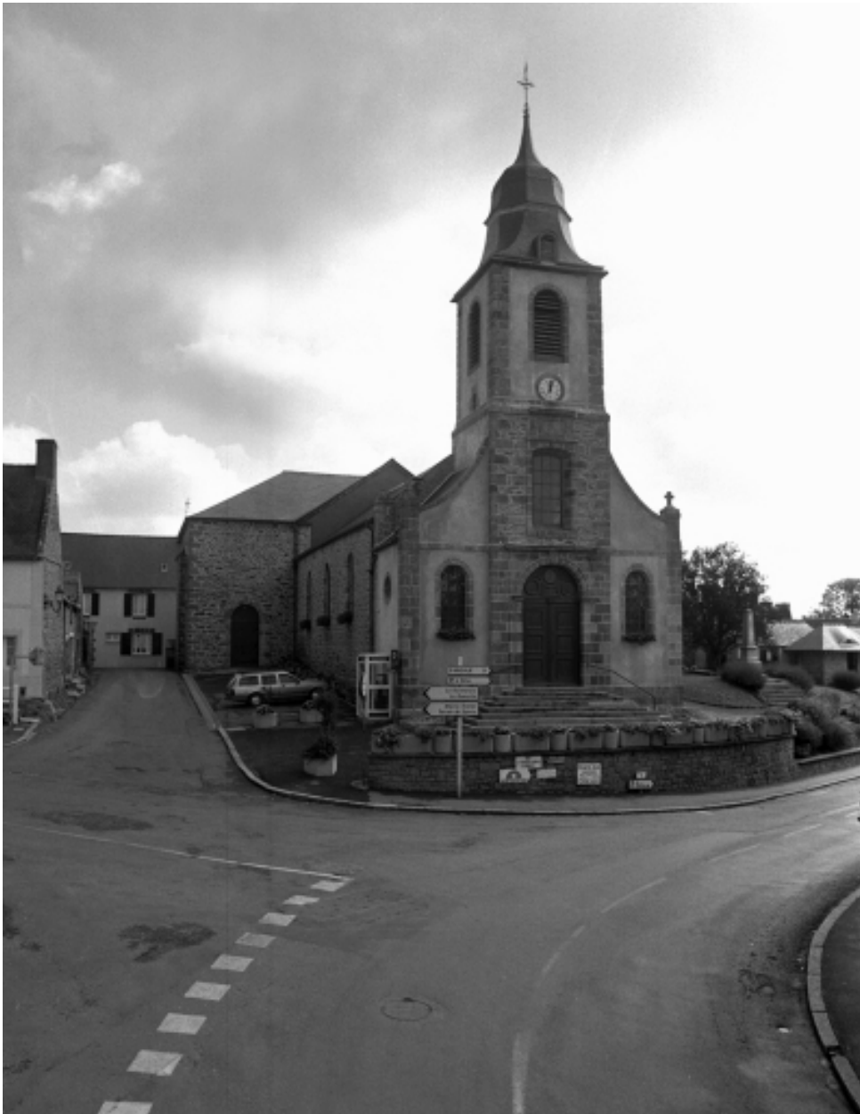
Vue générale ouest
