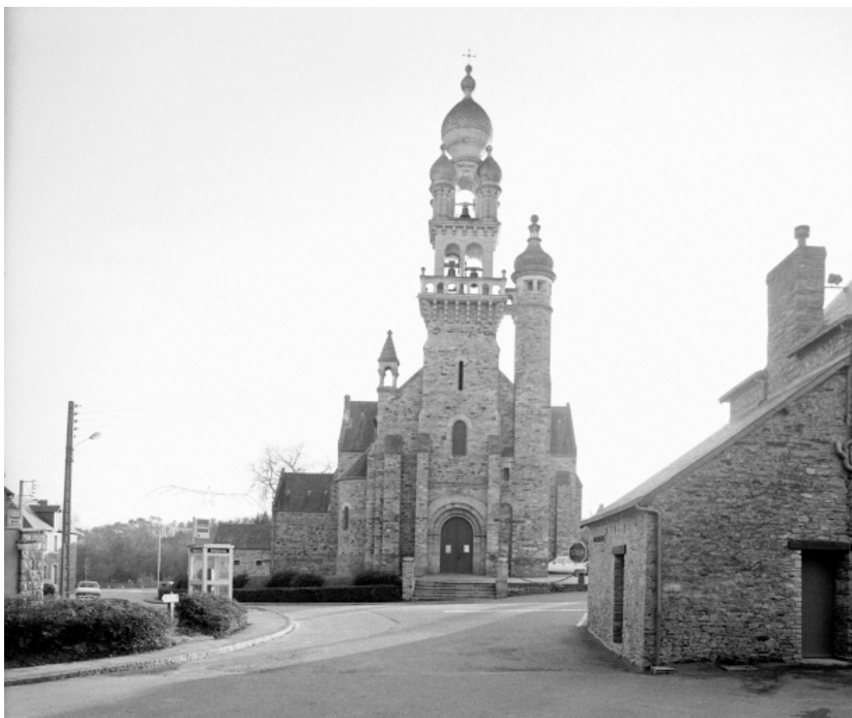
Elévation Nord : vue générale
