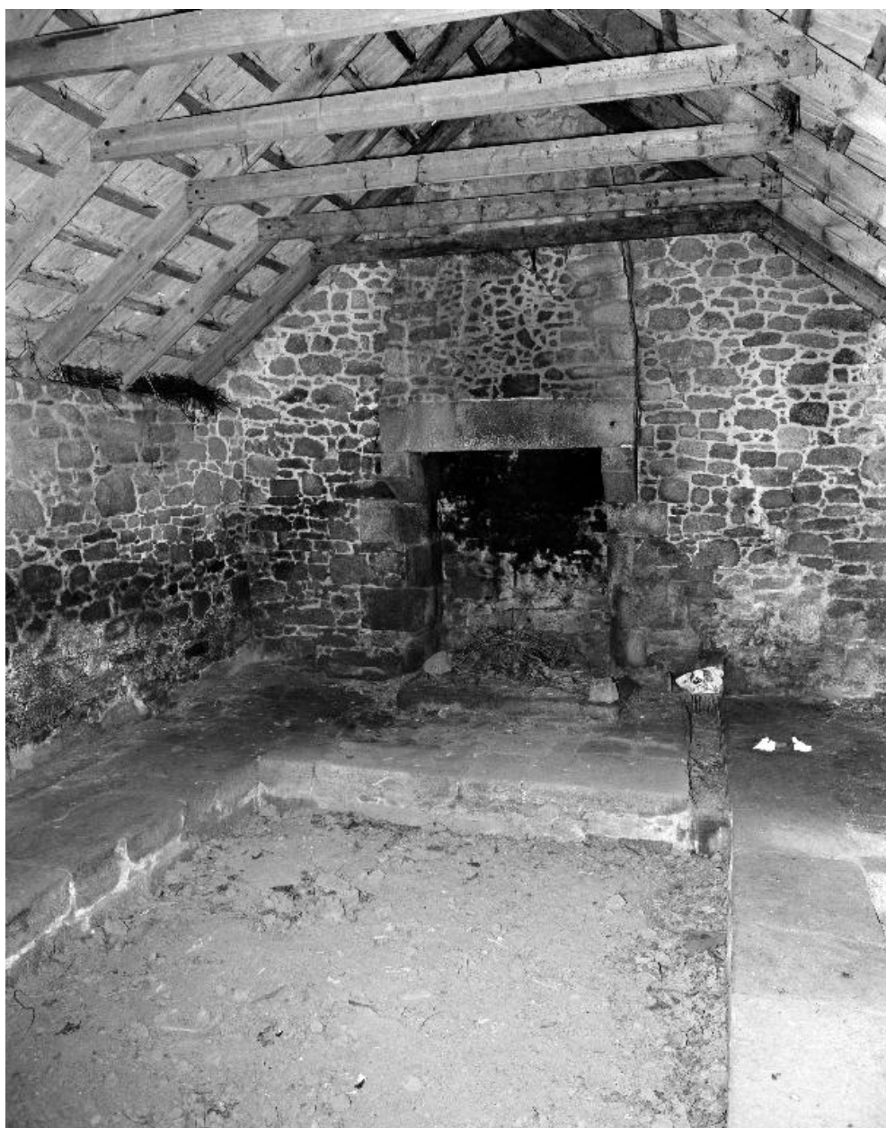
Lavoir, vue intérieure prise du sud-ouest
