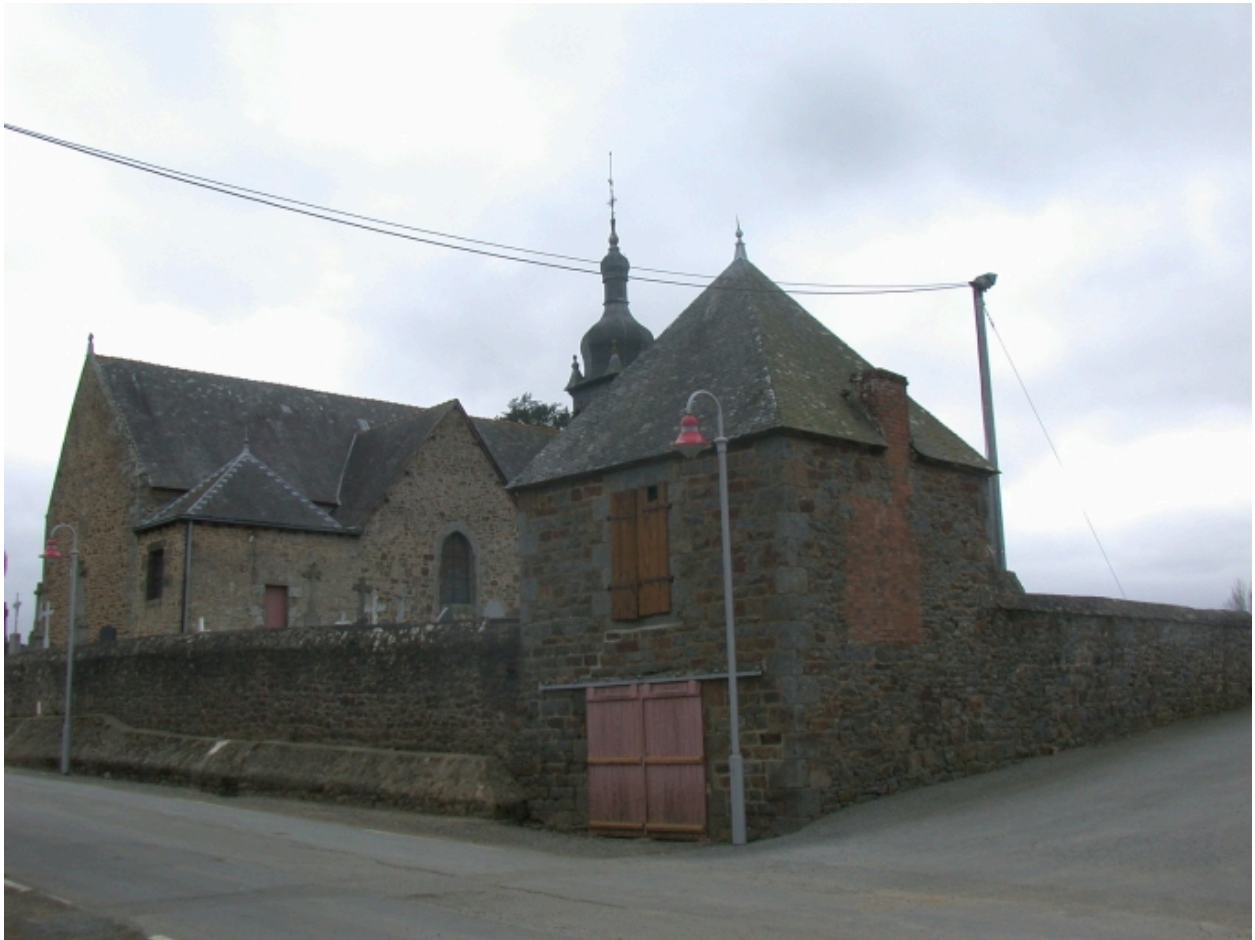
Pavillon Nord-Est, vue générale arrière
