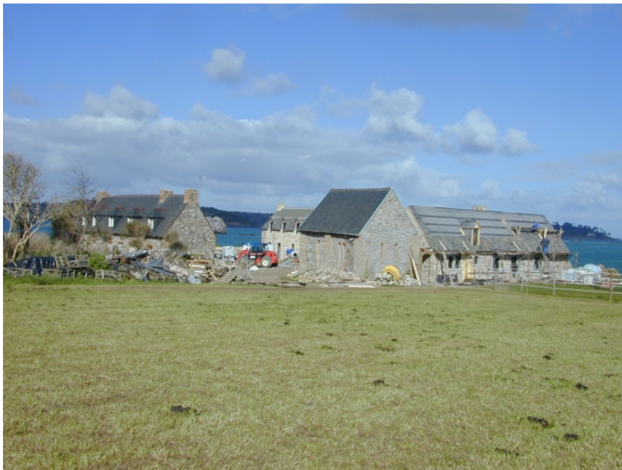
Vue des bâtiments en cours de restauration, 2004 (SRA)
