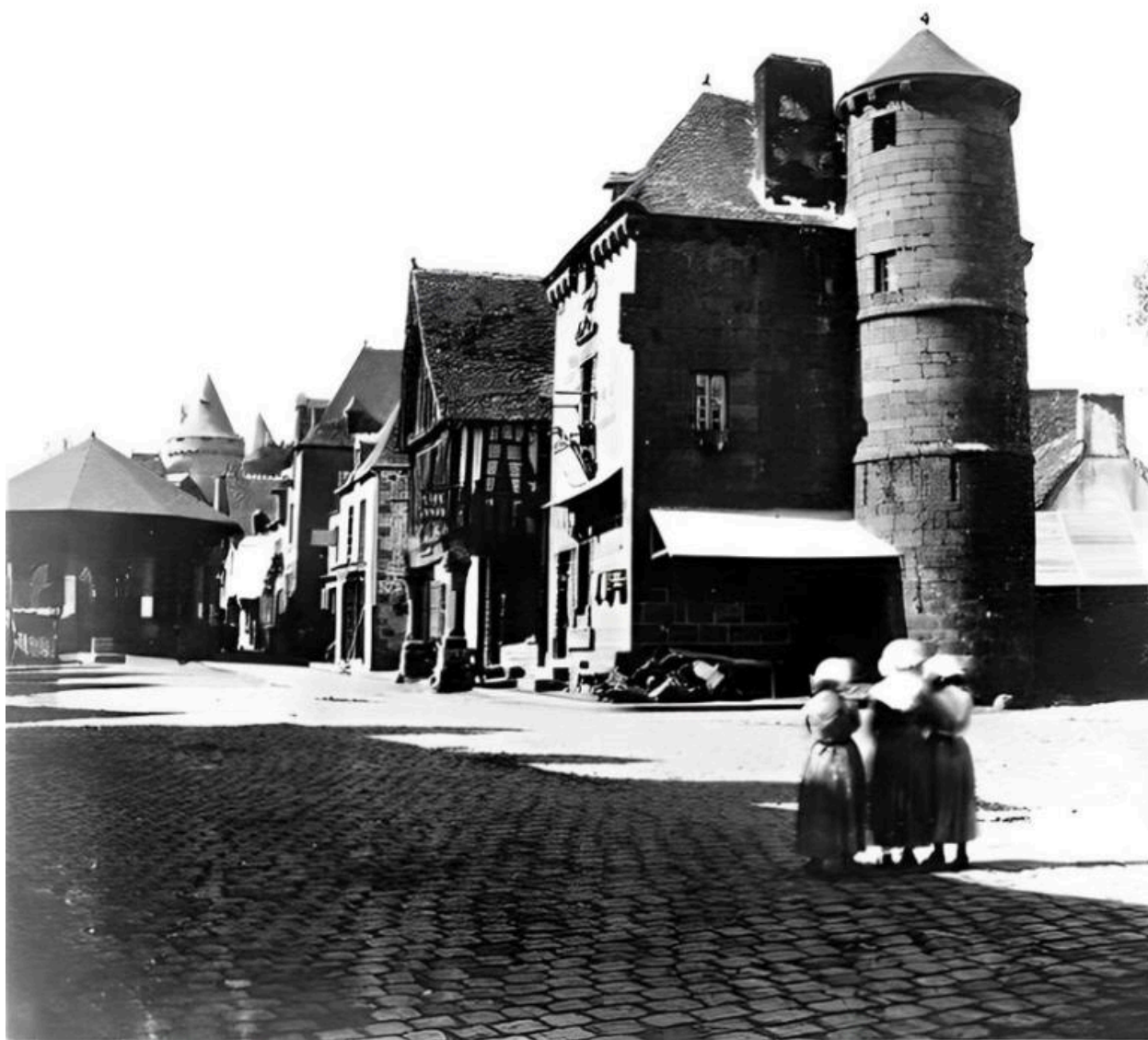
Vue de 1858 sur la Grand'Rue de Combourg avec la maison de la Lanterne, le porche, la halle et en fond le château
