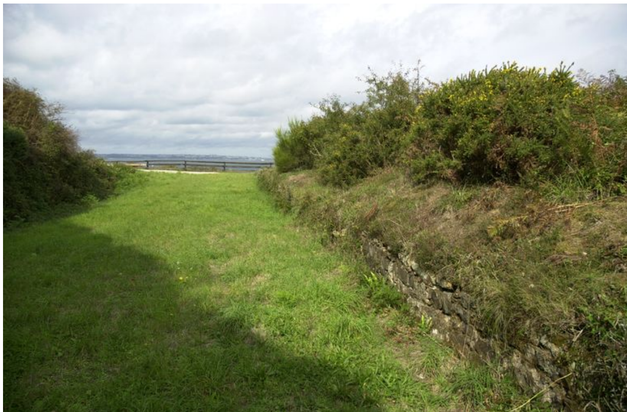
Vue du fort de Lanvéoc : batterie et parapet en maçonnerie
