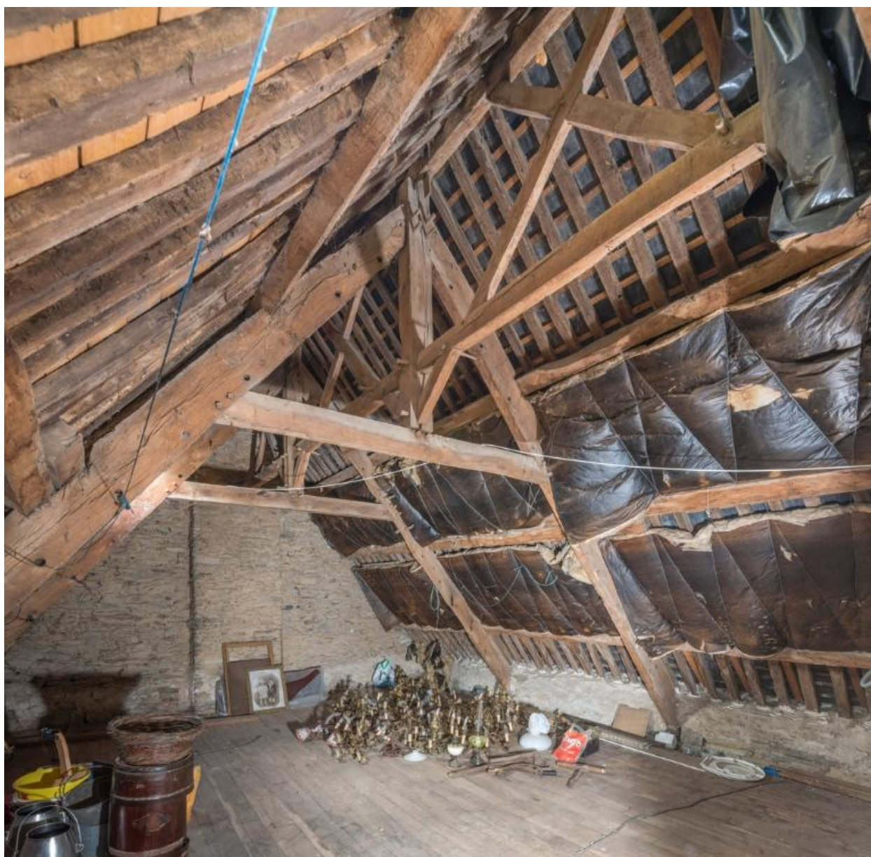
Logis 1774. Charpente à double faîtage. Vue générale
