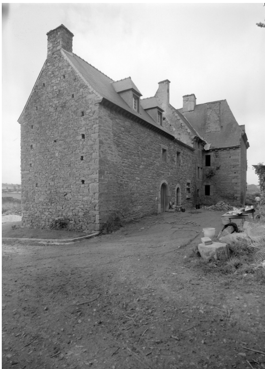
Vue vers le nord-est
