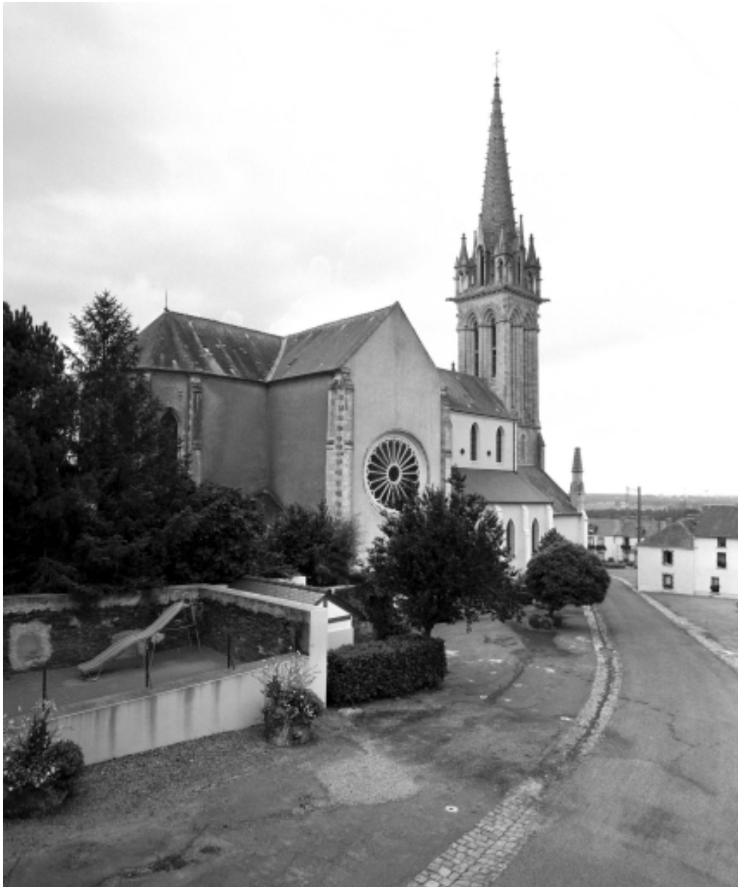
Vue générale ouest
