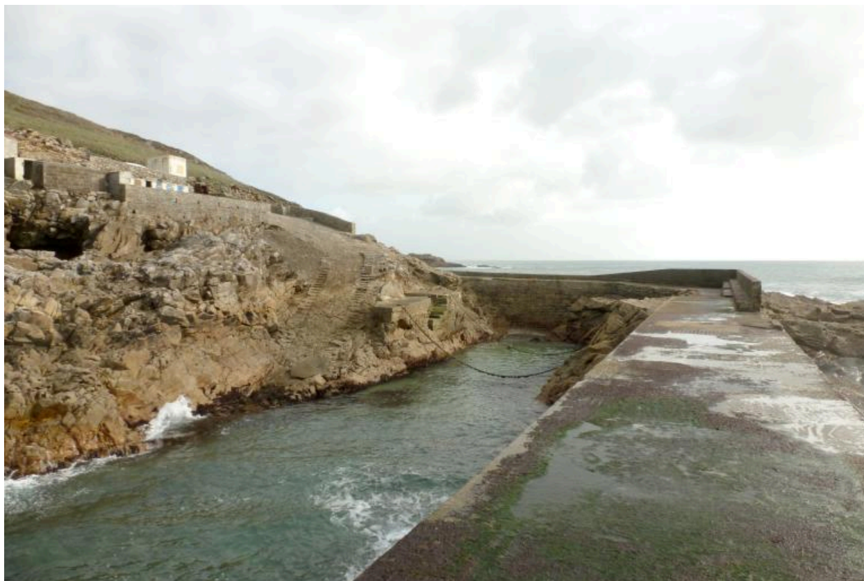
Chenal et barrage. Vue générale prise du nord.
