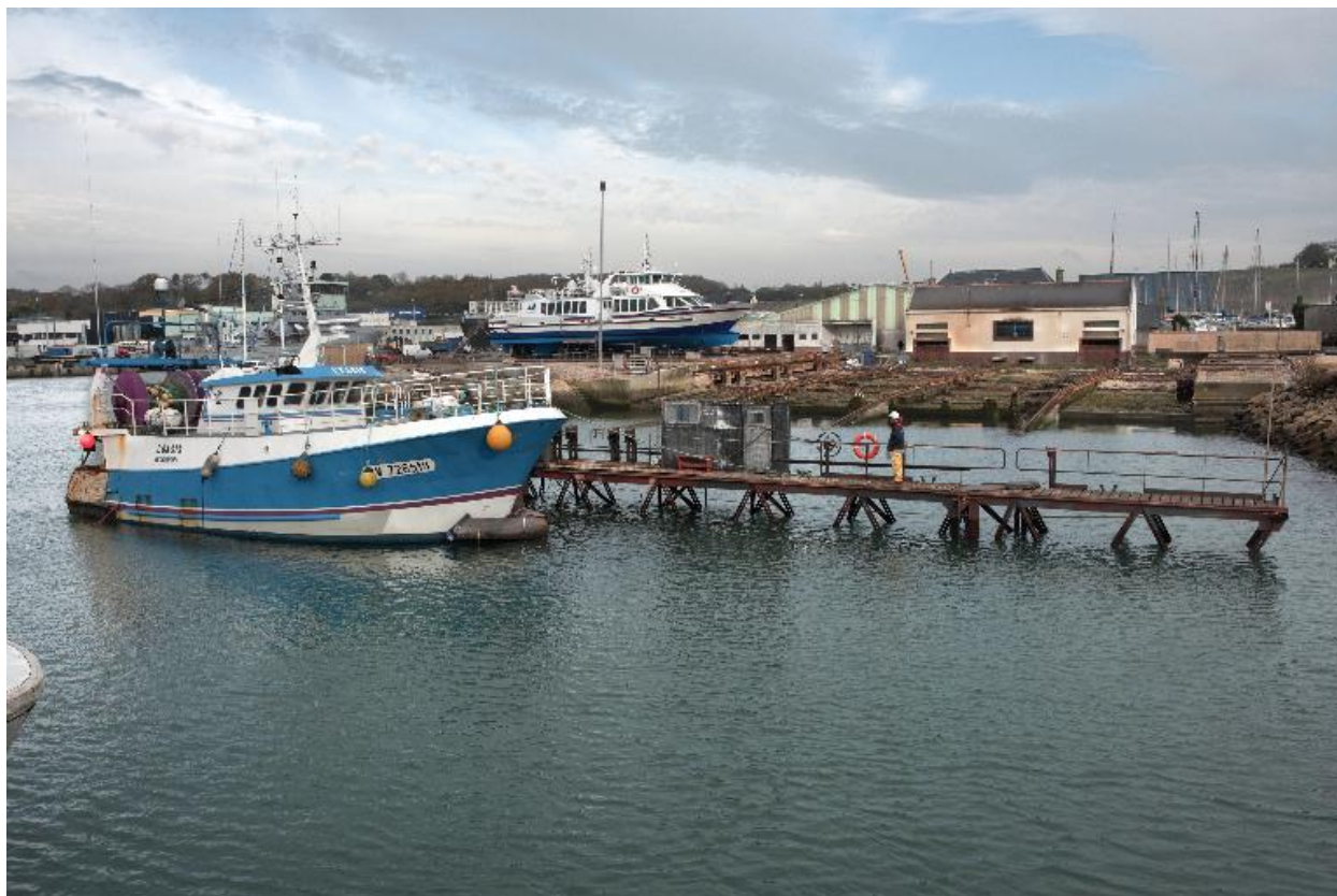
Passerelle, manoeuvre de mise à sec : vue générale
