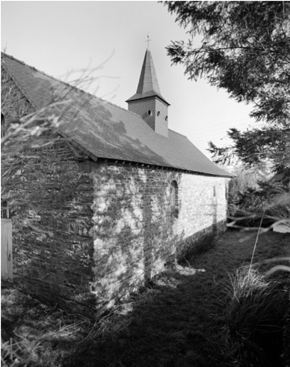
Vue partielle sud-ouest
