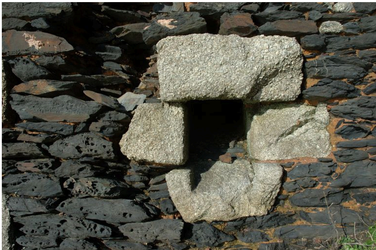
Vue de la batterie de Cornouaille : exutoire des latrines
