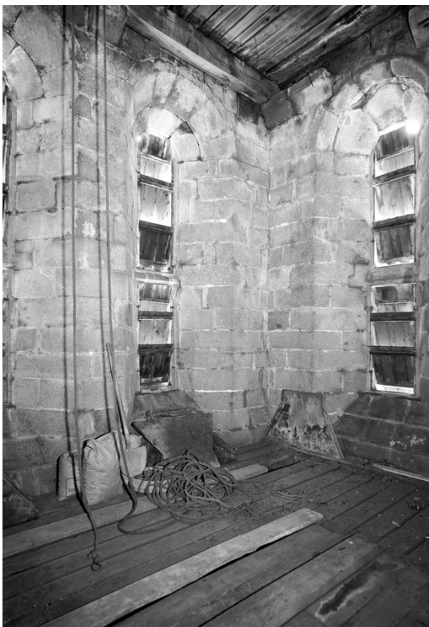
Tour 1er étage : vue générale prise du sud-est
