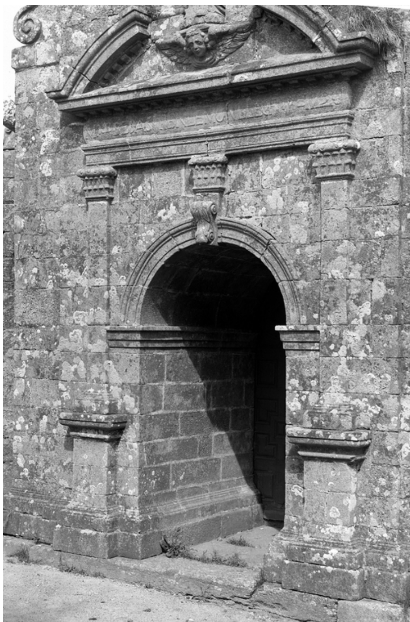
Tour du clocher, face ouest, 1er niveau : détail du porche
