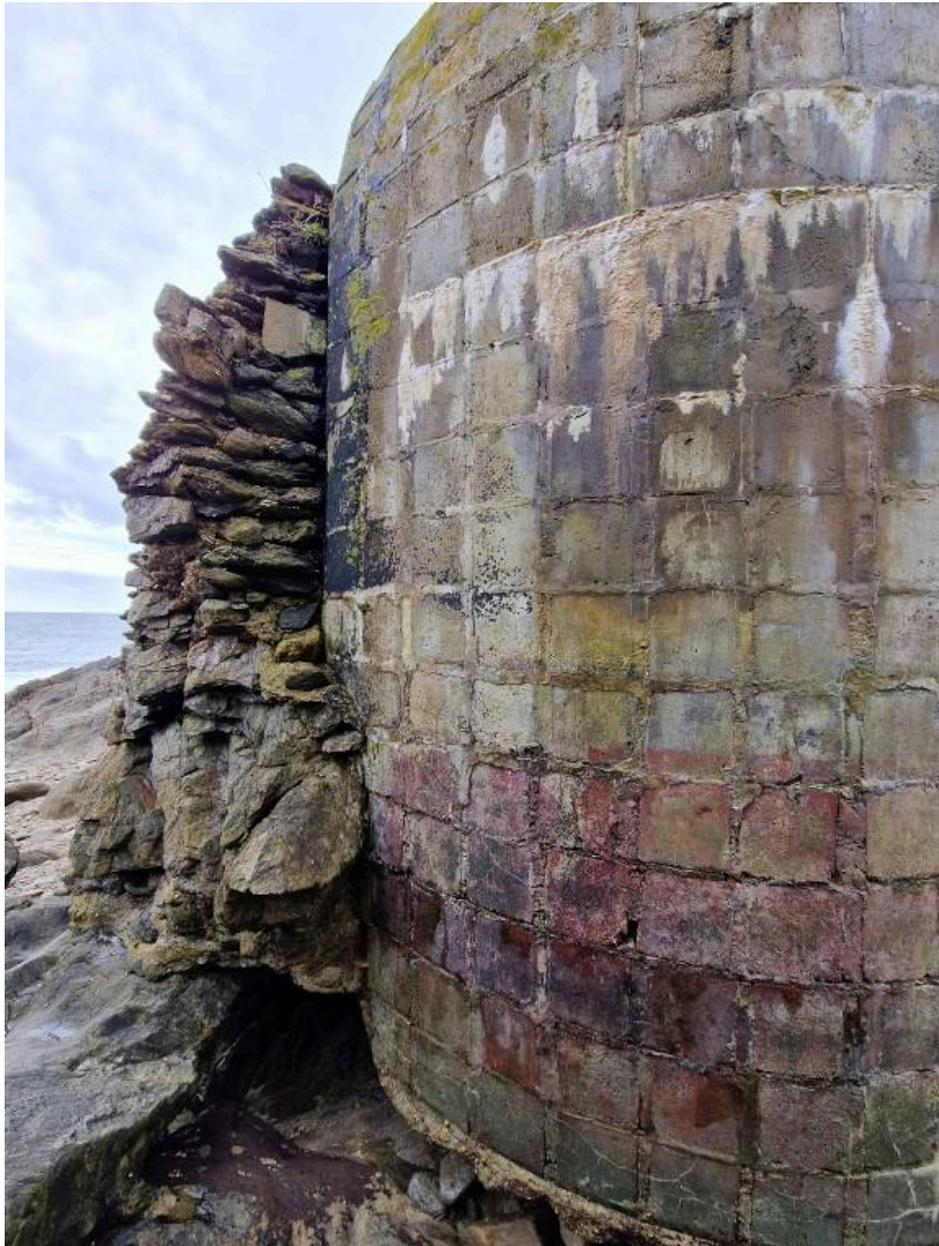
Vue de détail de l'angle nord-est. De ce côté de l'îlot, l'érosion marine a emporté le substrat. Le bunker est construit avec des parpaings dans lesquels a été coulé le béton ; il est recouvert d'une maçonnerie de moellon
