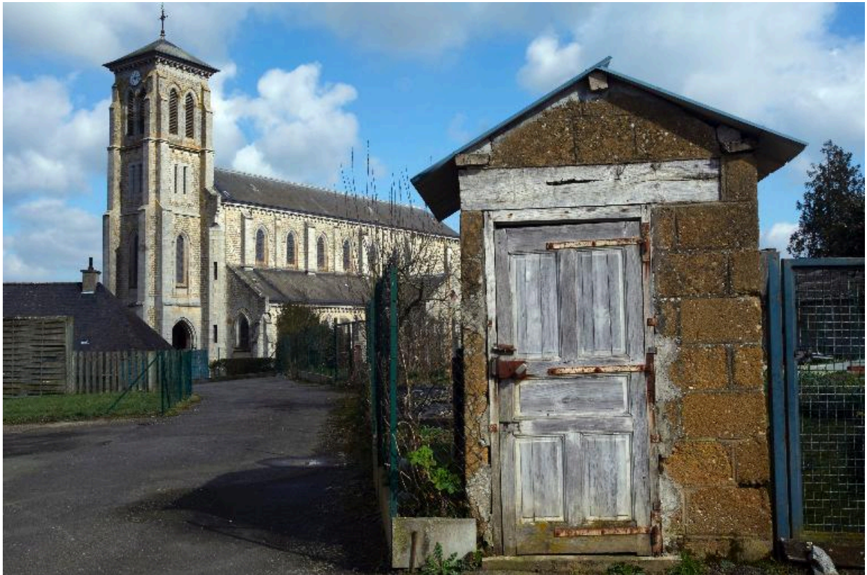
Vue de situation de l'église
