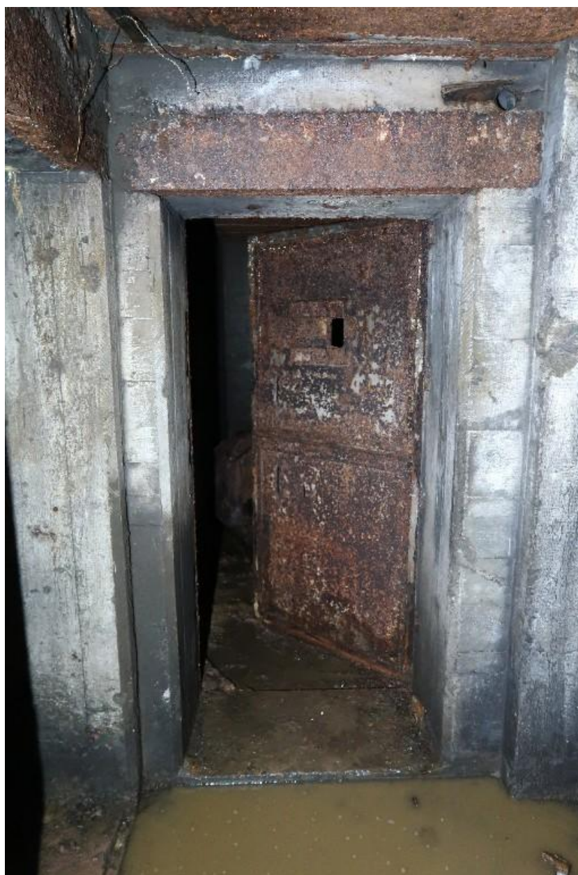
Vue de la porte blindée à deux vantaux de l'entrée nord du sas
