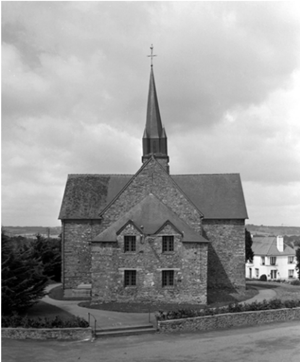
Le chevet et la sacristie : vue générale est
