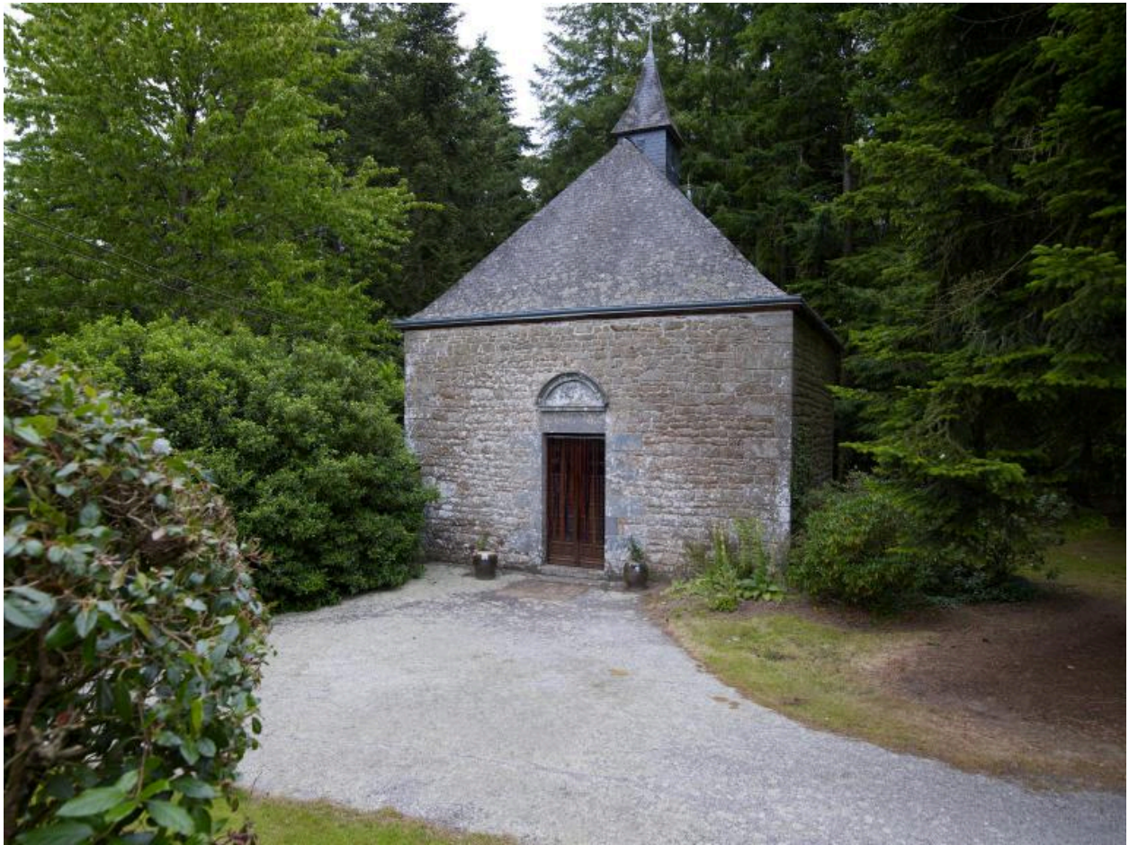
Vue générale de la chapelle
