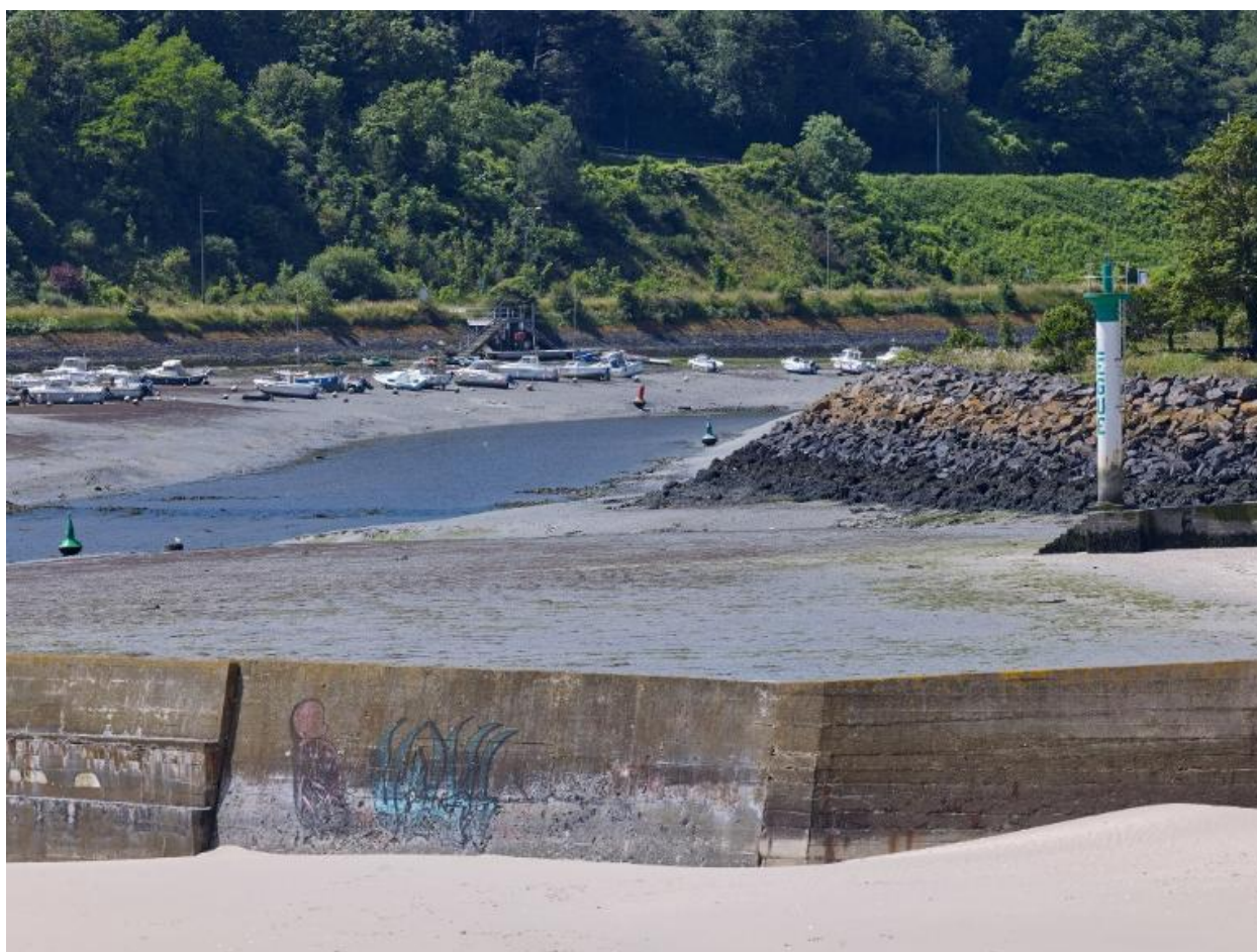
Le môle de Sous-la-tour à proximité de la jetée de la douane
