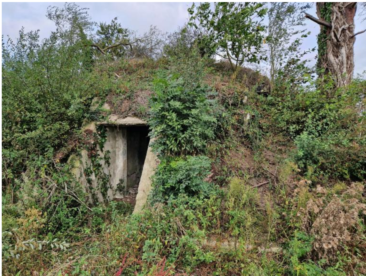
Vue de l'entrée située au sud
